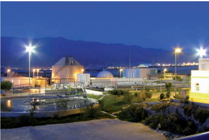
Night views of the WWTP in El Ejido (Almería).
