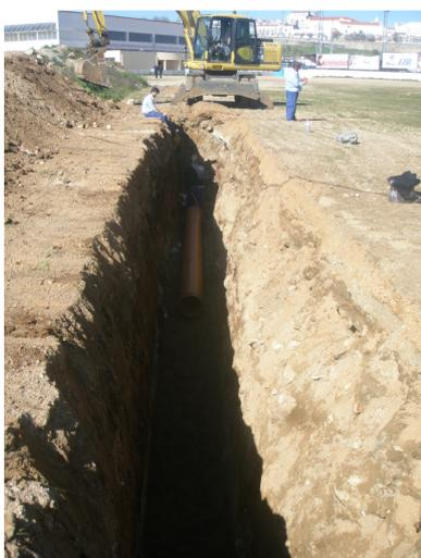
Imagem 2 – Instalação de conduta
