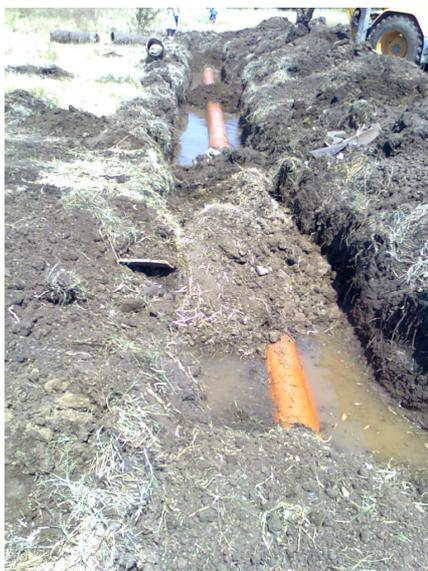
Imagem 7 – Instalação colector
