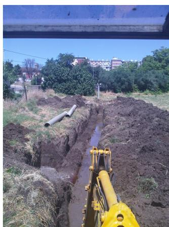
Imagem 6 – Instalação colector
