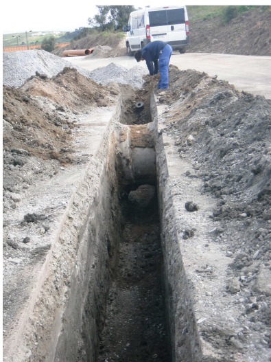
Imagem 1 – Instalação de conduta
